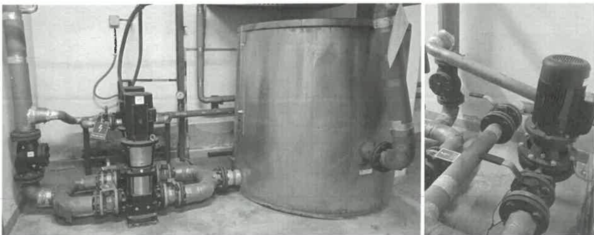
5. Zbiornik buforowy na instalacji „wody lodowej”, pompa obiegowa „wody lodowej” chłodnic Volcano
