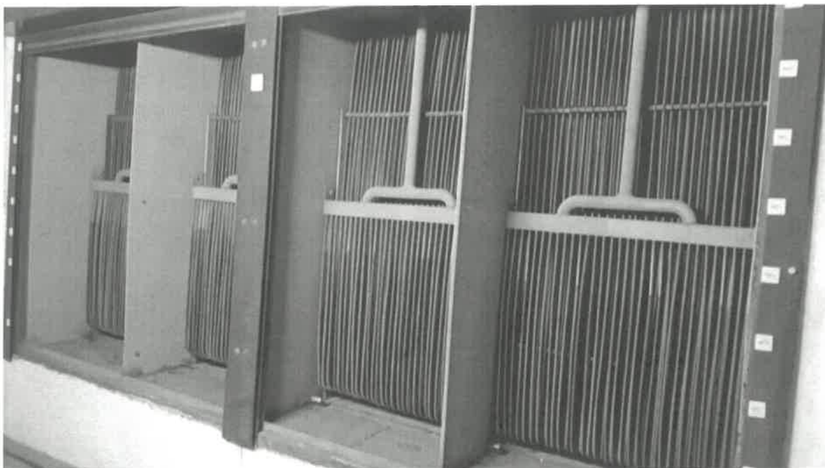
4. Chłodnice MK-CP/N/150 (4x150 kW)
